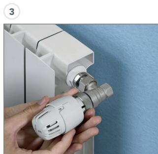
3. Positionner la tête thermostatique sur le corps de la vanne en centrant l'hexagone du capuchon et en laissant l'ouverture de référence de réglage dirigée vers le haut, ou bien en position visible.
