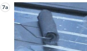
Il pavimento ceramico verrà incollato tramite comuni colle specifiche per incollaggio pavimenti (es. colle cementizie di classe C2E o su superiore) direttamente al pannello **KILMA FUTURA**.
