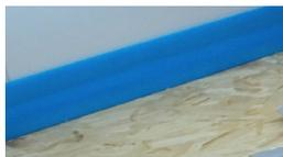
Posizionare la fascia perimetrale adesiva, **cod. 472.08.12**, su tutto il perimetro dei locali in cui si installerà l'impianto radiante e sul perimetro di tutti gli elementi edili che verranno a contatto con l'impianto stesso, così come sempre si deve fare in caso di posa di impianti radianti a pavimento.
