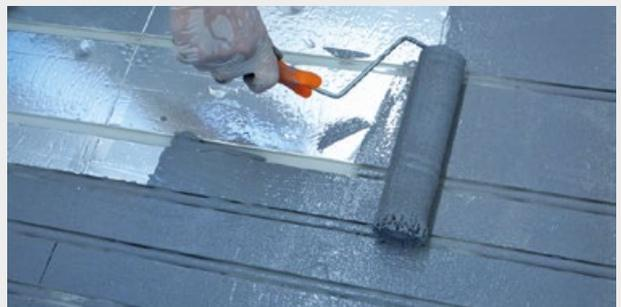
Prima di applicare pavimentazione ceramica o supporti a base cementizia (parquet incollato o pavimenti resilienti), applicare primer epossidico RBM MF by Mapei e, in seguito, il primer aggrappante.
