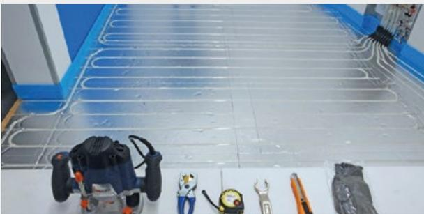
Prima della posa della pavimentazione effettuare la prova di tenuta dell'impianto, come previsto dalla norma.
