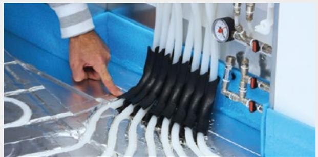
I reggicurva evitano il possibile schiacciamento delle tubazioni in prossimità dell'ingresso delle stesse nel pannello.
