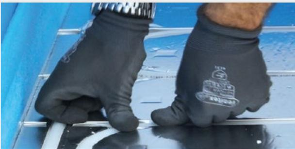
La tubazione deve assolutamente restare ben incassata sotto la superficie del pannello. Applicare il nastro adesivo alluminato sulle curve o dove necessario per tenere in sede il tubo.
