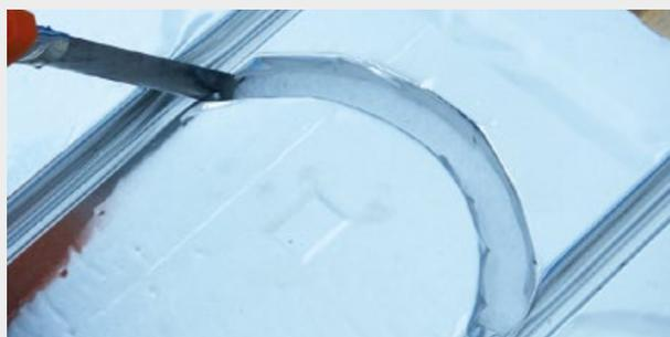
In corrispondenza delle curve la traccia è già predisposta, basterà quindi incidere lo strato superficiale di alluminio, liberando il sottostante alloggiamento preformato per il tubo.
