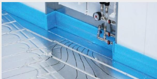
Taglio di una nuova traccia / guida per il tubo: potrebbe essere necessario realizzare in loco una nuova traccia per completare uno o più circuiti o per crearne di nuovi.
